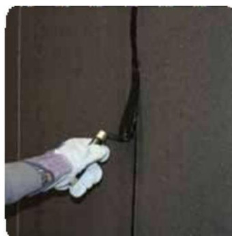
Фигура3 Нагрейте всички странични презастъпвания с горелка и използвайте заоблена мистрия, за да създадете перфектно залепване на разтопения битум.
